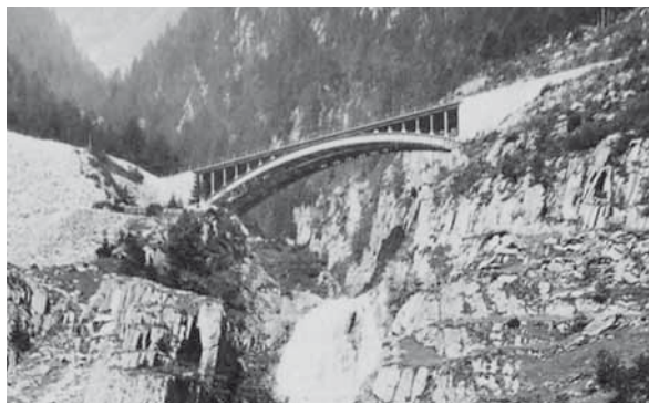
Die 61 m langen Rohrbachbrücken zwischen Wassen und Göschenen wurden Anfang der 1980er Jahre durch eine Tunnelbrücke (geschlossene und lawinensichere Röhre an den Naxbergtunnel angebaut) ersetzt.
