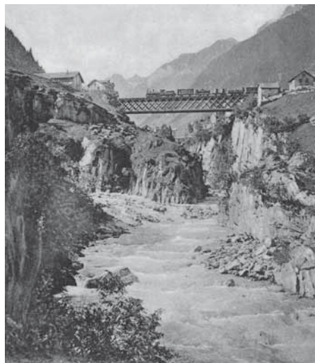
Die 65 m lange Göschenenreussbrücke unmittelbar vor dem Bahnhof Göschenen in den ersten Betriebsjahren; die letzte noch vorhandene Brücke aus der Gründungszeit der Gotthardbahn wird heute für den Strassenverkehr genutzt. Fotos: Sammlung R. Karpf
